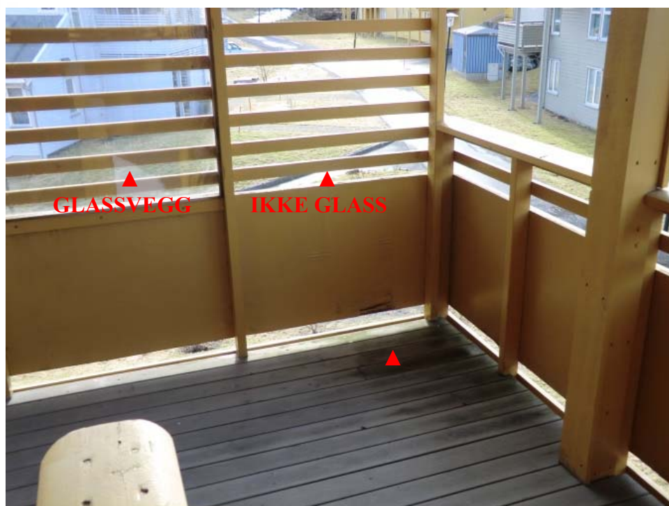
Bilde 2 viser forskjellen på gulv med oppsatt og ikke oppsatt glassvegg i en av trappeoppgangene. Der det ikke er glass, er gulvet grønt av alger, noe som over tid vil føre til råteskader hvis ikke gulvet oljes eller beises ofte. Borettslaget har ansvar for å vedlikeholde disse gulvene.
